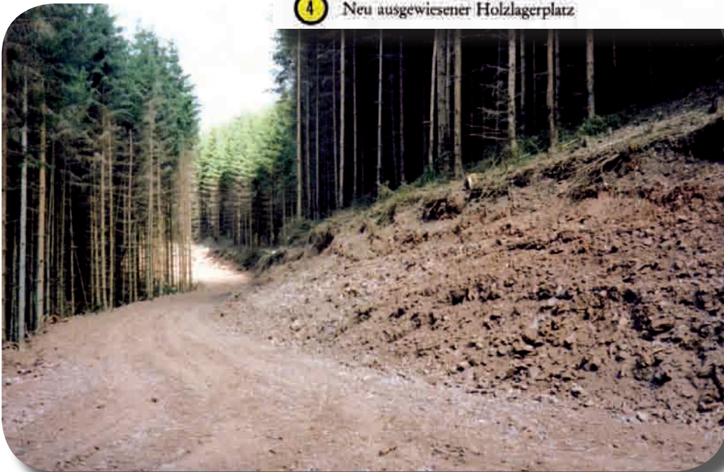
Abb. 52 bis 54: Das Beispiel zeigt das in der Bodenordnung geschaffene System von Fahr- und Rückewegen sowie Holzlagerplätzen zur Nutzung der Waldbestände. Oft können Privatholzbestände ohne Erschließungsmaßnahmen überhaupt nicht genutzt werden.
